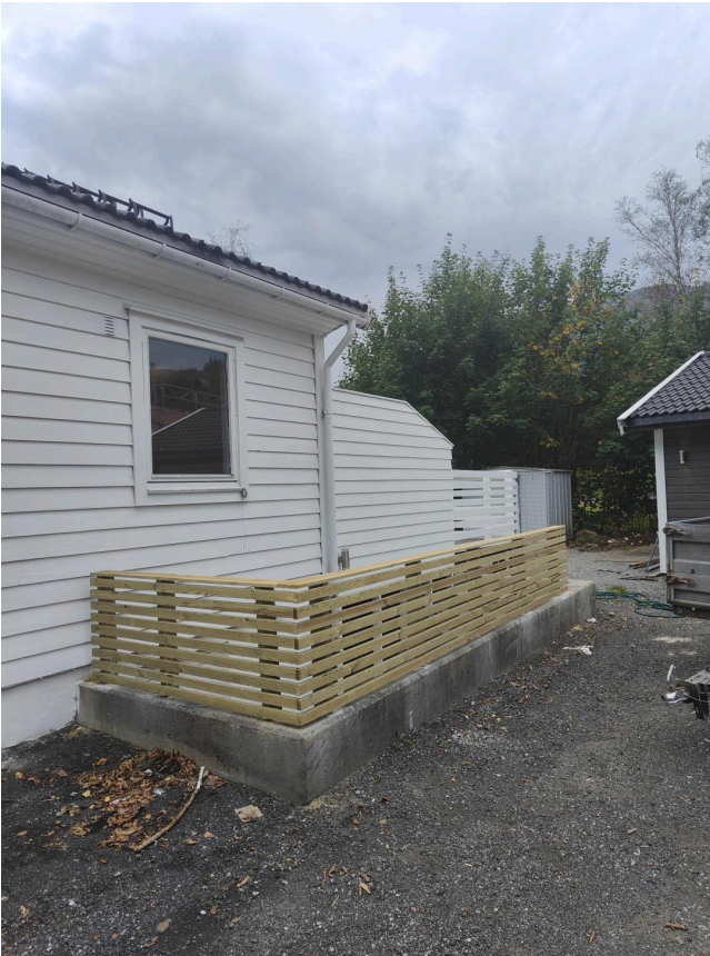
Rekkverk montert etter befarings.
