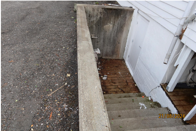
Grunnmur av malt betong og pusset malt Leca.
