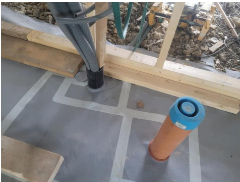
Bilder av radonduk i forbindelse med oppføring av boligen.
