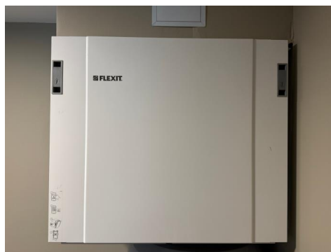
Luftbehandlingsaggregat på vaskerom.
