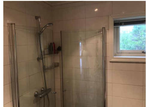
Bildet viser vindu i våtsone.
