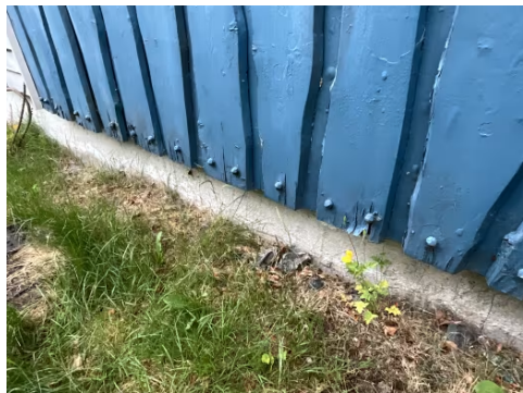
Råteskader.
