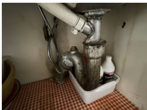
Avløp i kjøkken.
