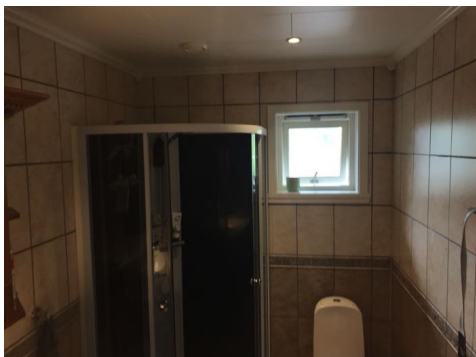
Bildet viser vindu i våtsone.
