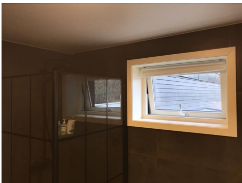
Bildet viser vindu i våtzone.
