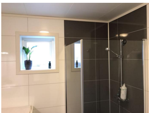
Bildet viser vindu i våtzone.
