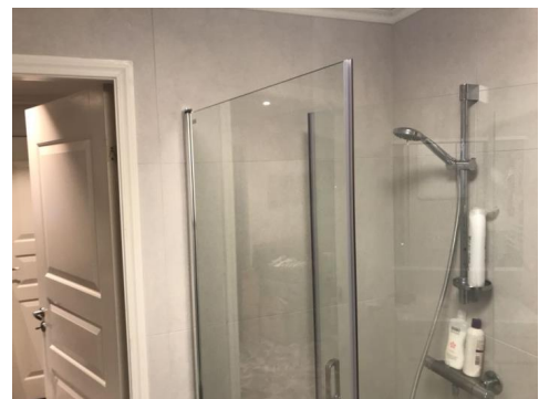
Bildet viser dør i våtsone.
