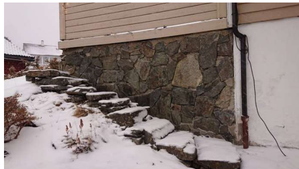
Forstøtningsmur i naturstein til terrasse i sør.
