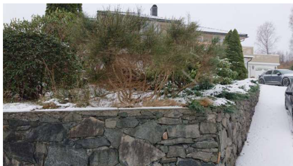
Naturstein forstøtningsmur mot kommunal veg og oppkjørsel.
