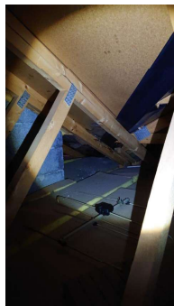
Skader i sutaksplater på østside av pipe m.m. Fuktmerker på treverk.
