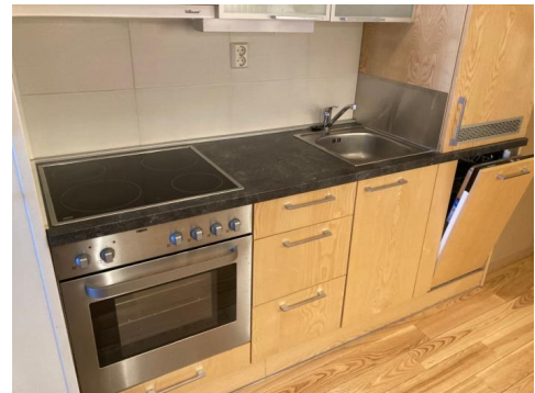
Skade i overflate
