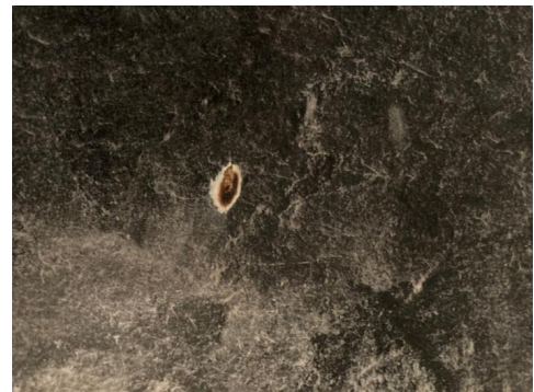
Skade/sår i benkeplate
