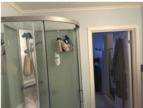
Bildet viser dør i våtsone.
