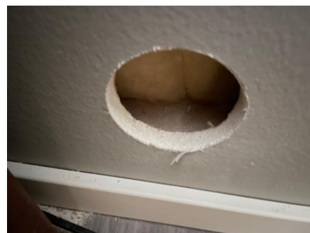
Hullboring (73 mm i diameter) for visuell inspeksjon.
