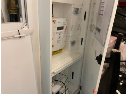
Sikringskapskap/svakstrømskaps
