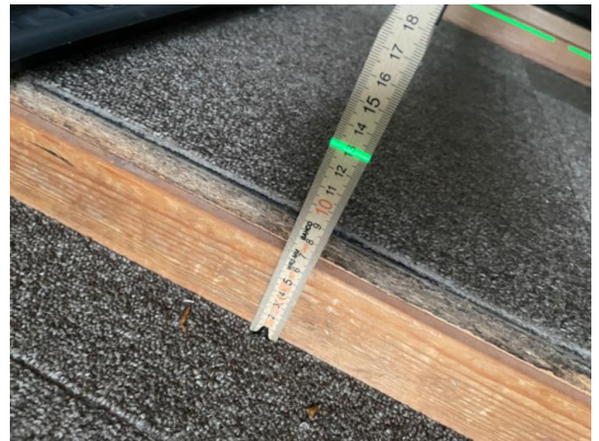
Kontroll av fallforhold/nivåforskjeller
