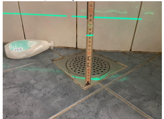
Kontroll av fallforhold/nivåforskjeller
