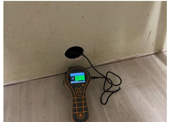
Hulltaking og kontroll av fuktverdier
