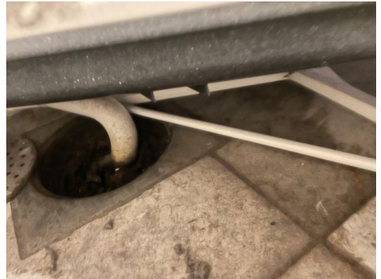
Kontroll av sluk/membran
