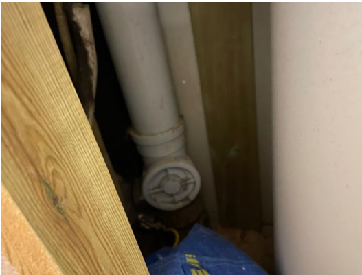
Stakeluke på vaskerom
