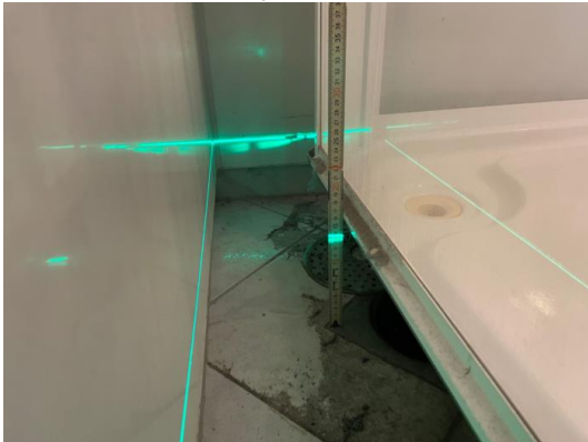
Kontroll av fallforhold/nivåforskjeller
