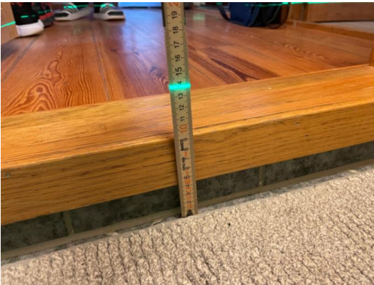
Kontroll av fallforhold/nivåforskjeller
