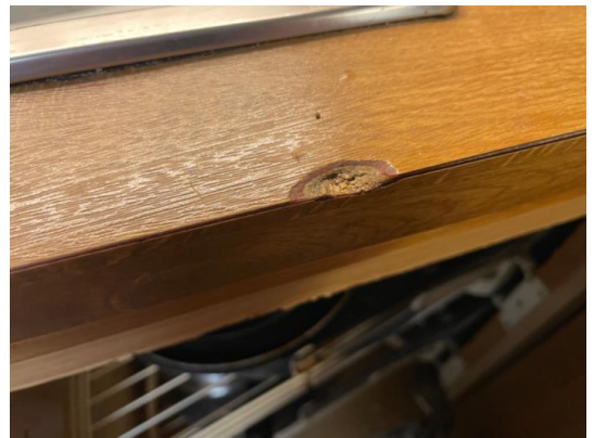
Stedvis hakk/merke/fuktsvelling
