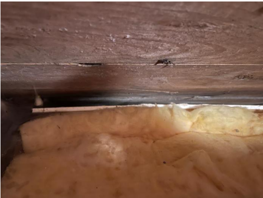
Ufagmessige løsninger ifb. med isolering av loft
