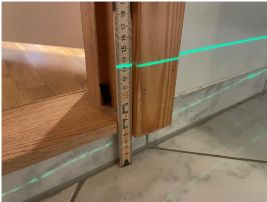
Kontroll av fallforhold/nivåforskjeller
