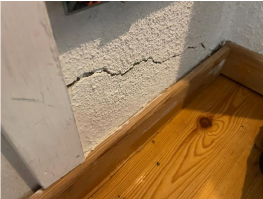
Innvendig oppsprekking
