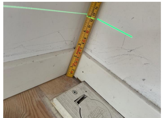
Lite parti med skjelt gulv på loft
