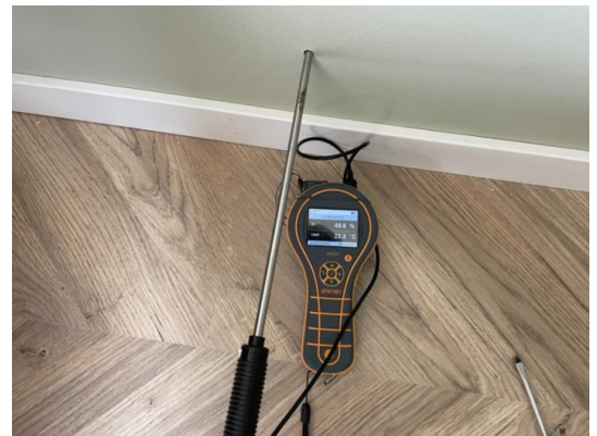
Kontroll med fuktprobe
