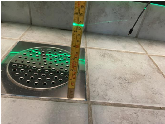
Kontroll av fallforhold/nivåforskjeller
