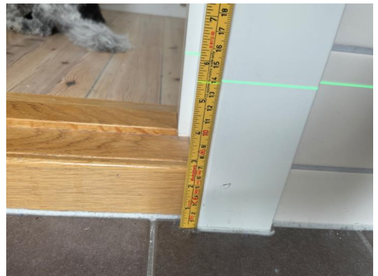
Kontroll av fallforhold/nivåforskjeller
