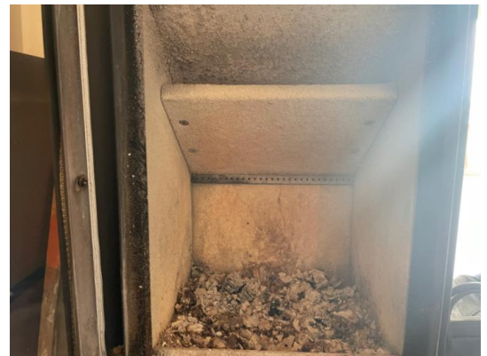
Kontroll av ildsted
