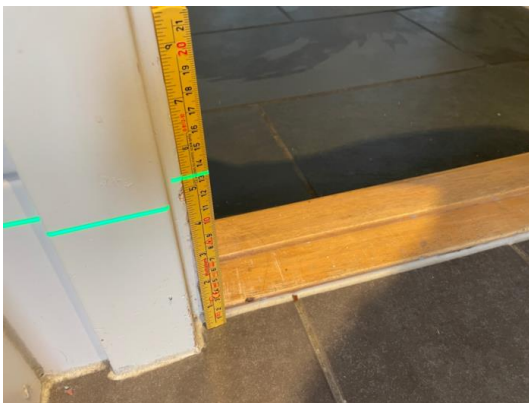
Kontroll av fallforhold/nivåforskjeller
