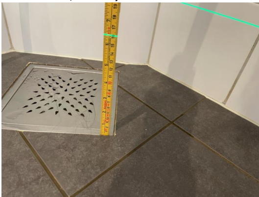
Kontroll av fallforhold/nivåforskjeller
