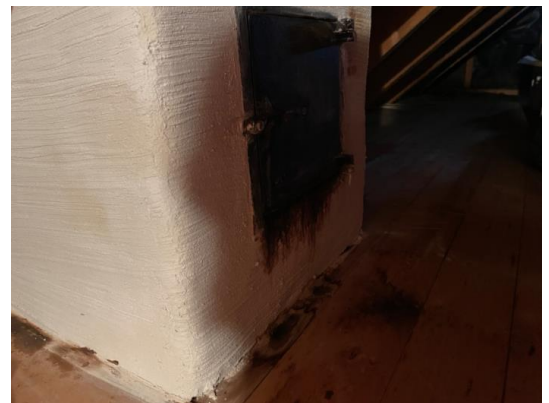
Kontroll fra kaldloft
