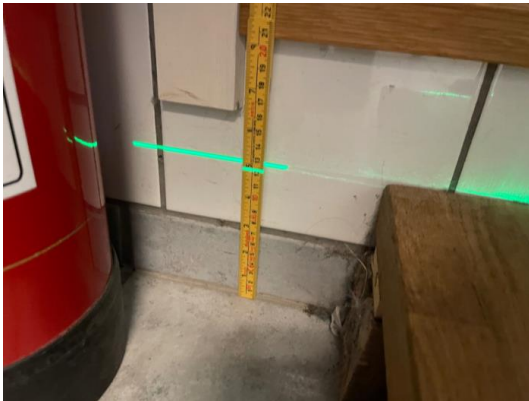
Kontroll av fallforhold/nivåforskjeller
