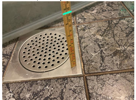
Kontroll av fallforhold/nivåforskjeller
