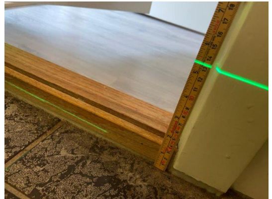
Kontroll av fallforhold/nivåforskjeller
