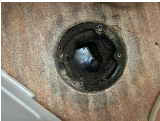
Eldre tettesjikt/slukløsning
