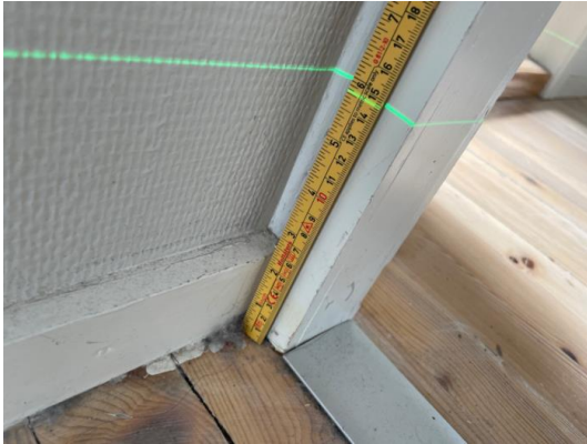
Lite parti med skjelvt gulv på loft
