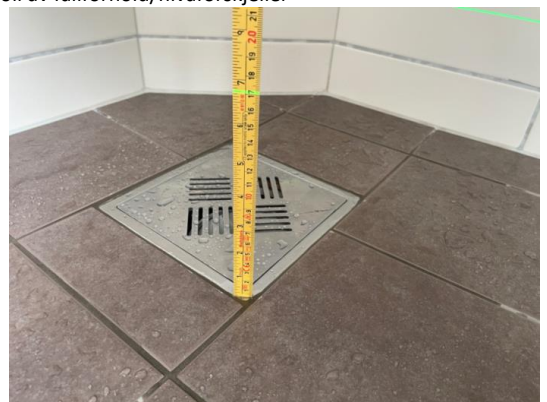
Kontroll av fallforhold/nivåforskjeller
