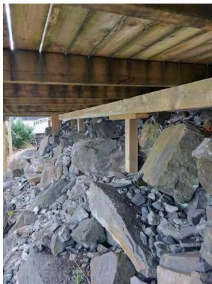
Det er utført arbeider med understøtting av terrassedekke i 2023
