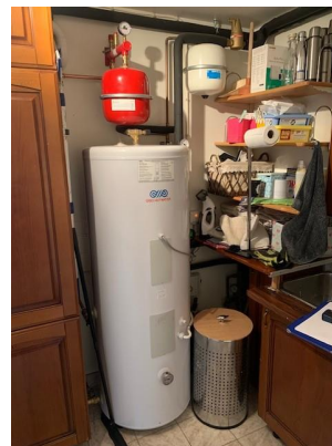
Vaskerom: Bereder type OSO OC 300 dobbeltmantlet bereder fra 2020
