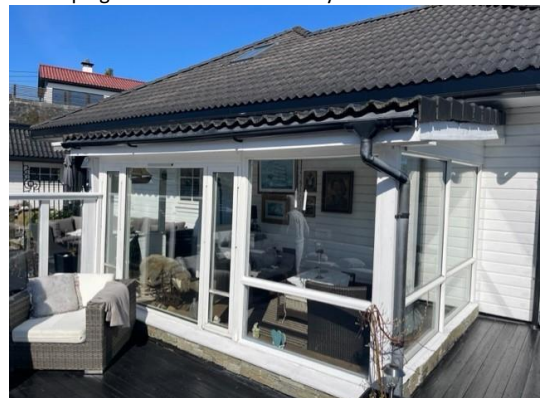
Sommerstue på gavlsiden av huset mot syd
