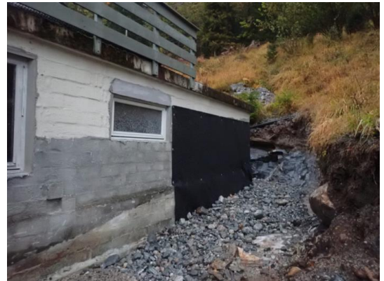
Utvendig grunnmur ved garasje
