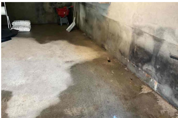
Gulv i garasje
