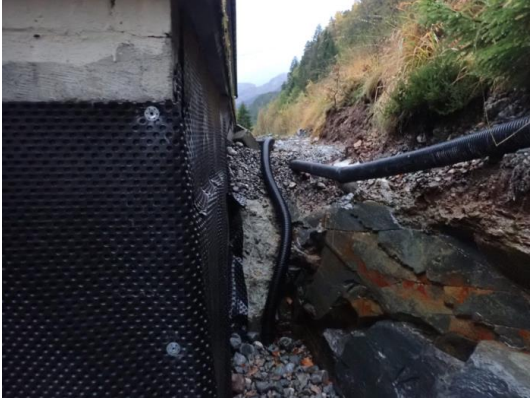
Utvendig grunnmur ved garasje
