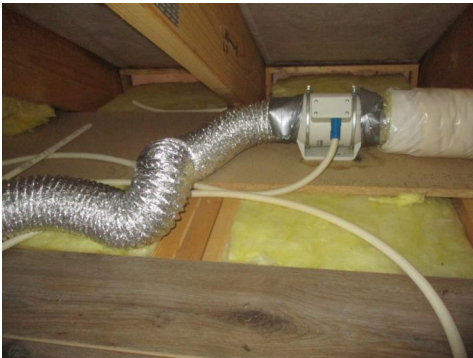
El-avtrekk frå wc (uisolert/isolert kanal)
