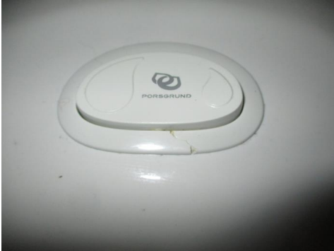
Sprekk i infesting til trykk-knapp
